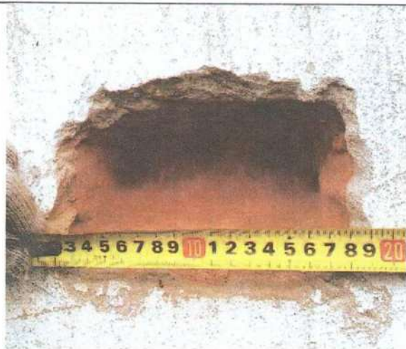
Фото 12. Зондаж №3. Стена 1-го этажа по оси Е в осях 5-6
