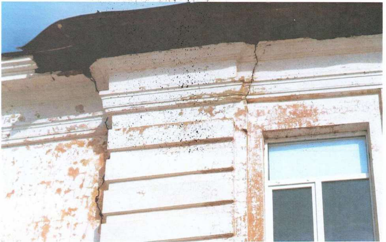
Фото 2. Главный фасад – стена по оси А.
