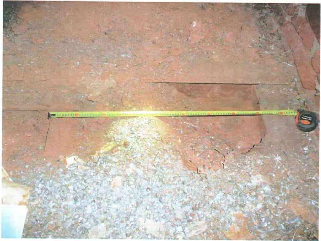
Фото 25. Вскрытие №2 перекрытия 2-го этажа.
