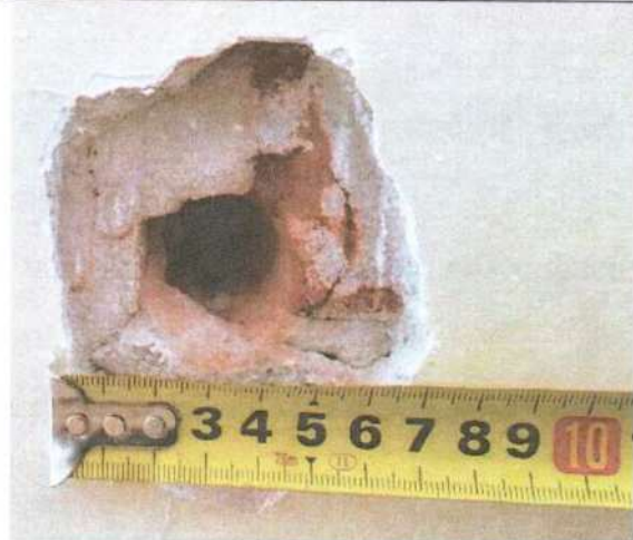
Фото 13. Зондаж №4. Стена 2-го этажа по оси А в осях 1-2
