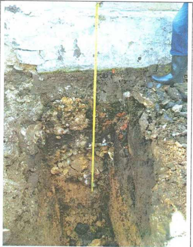
Фото 7. Общий вид шурфа №2
