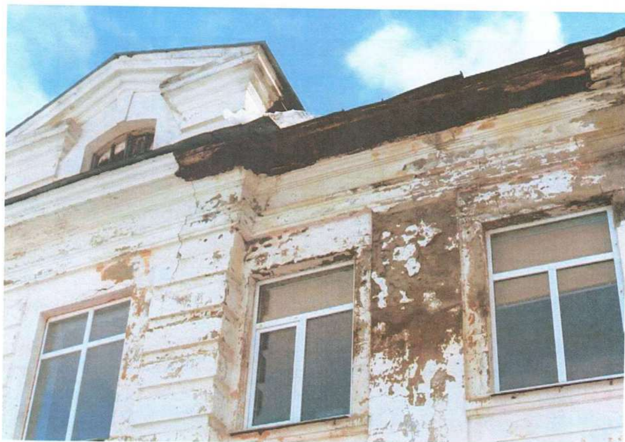
Фото 6. Боковой фасад – стена по оси 3.
