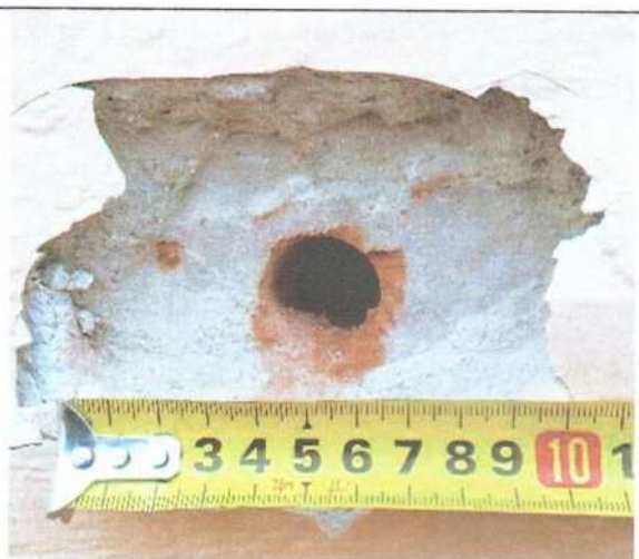
Фото 14. Зондаж №5. Стена 2-го этажа по оси 1 в осях Ж-З
