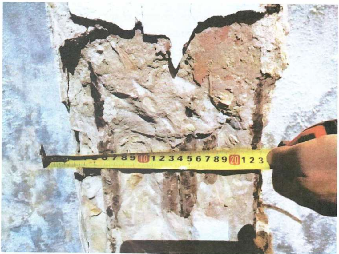
Фото 18. Вскрытие №2 железобетонной балки перекрытия подвала
