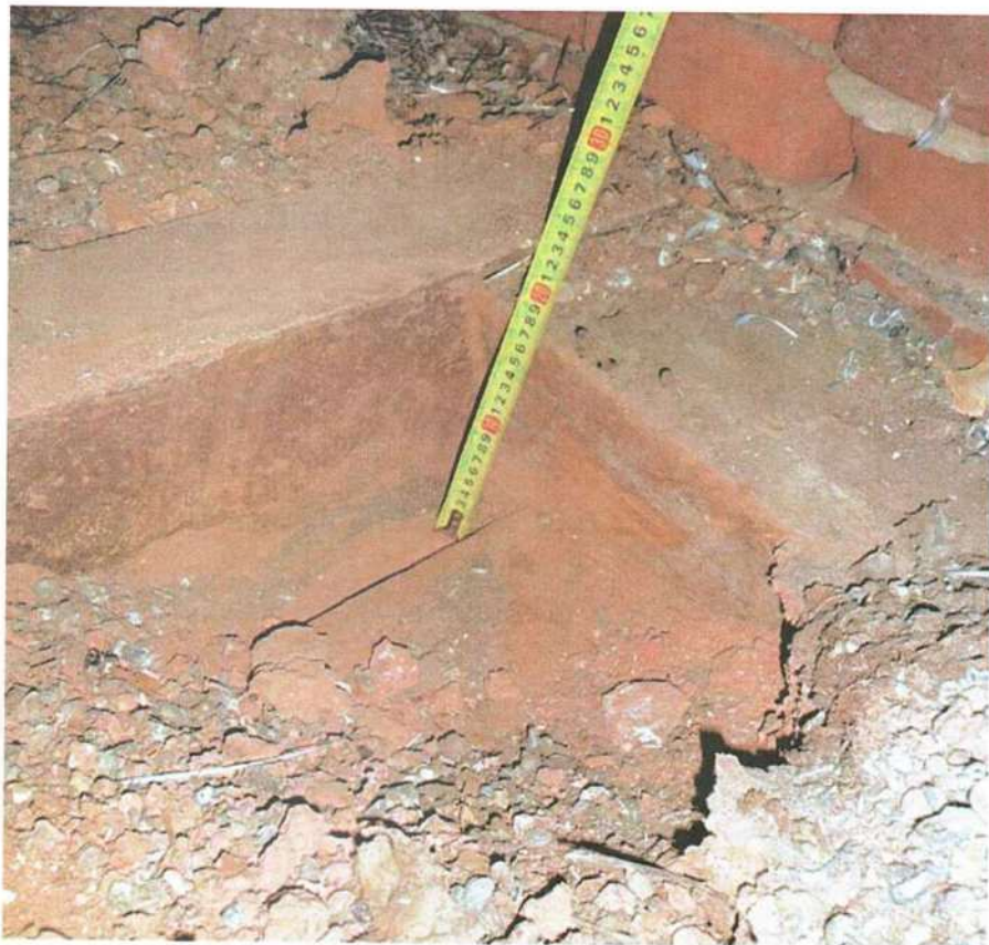
Фото 26. Вскрытие №2 перекрытия 2-го этажа.
