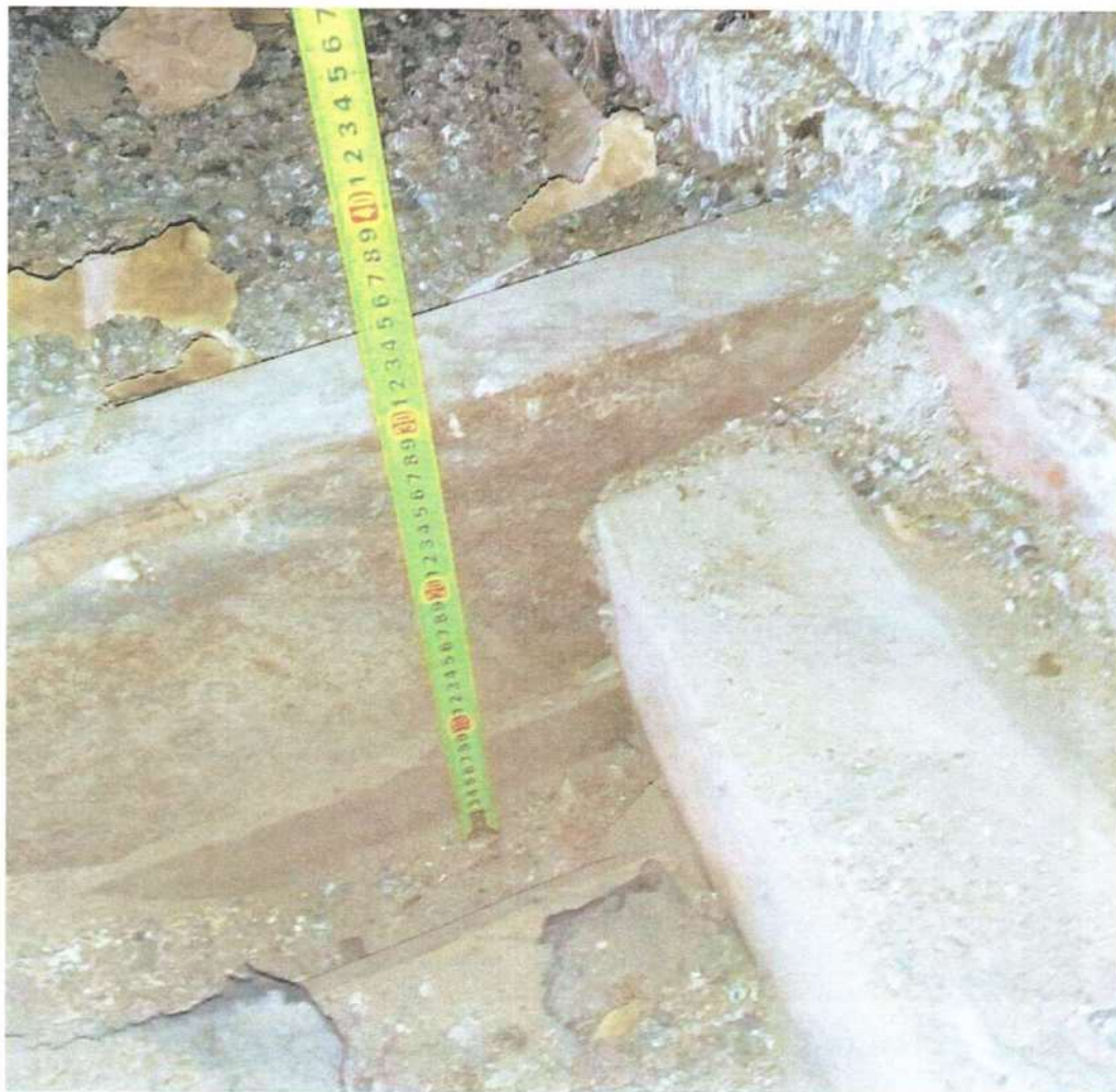
Фото 30. Вскрытие №4 перекрытия 2-го этажа.
