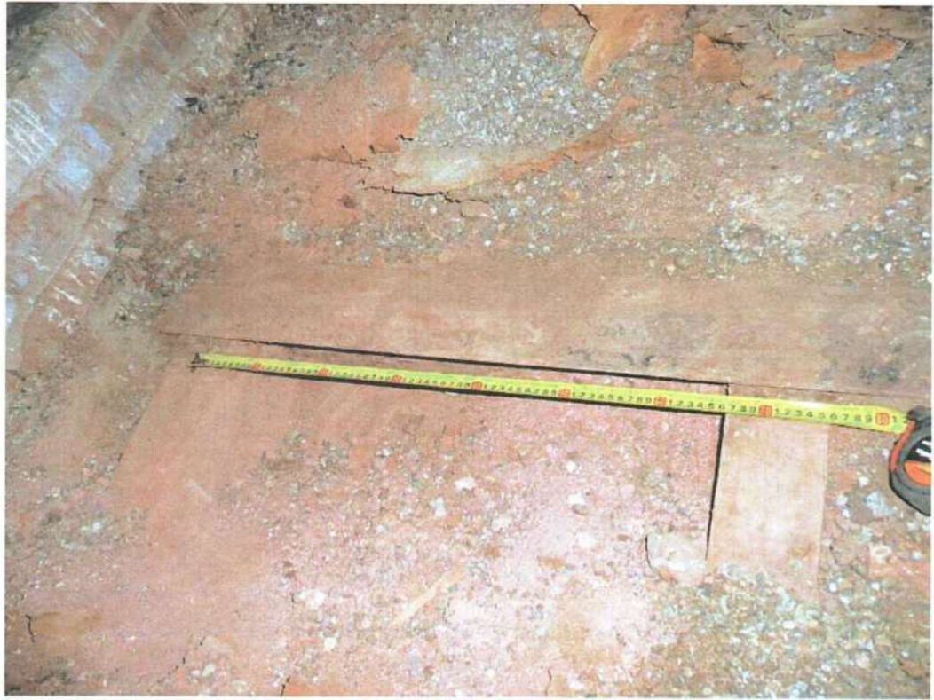
Фото 27. Вскрытие №3 перекрытия 2-го этажа.
