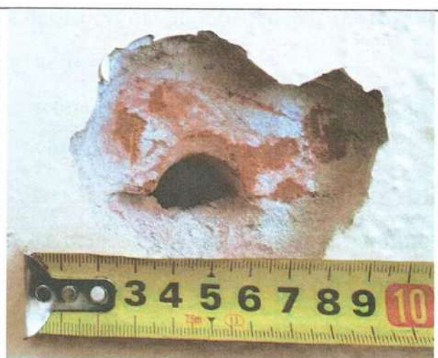
Фото 15. Зондаж №6. Стена 2-го этажа по оси 3 в осях 5-6
