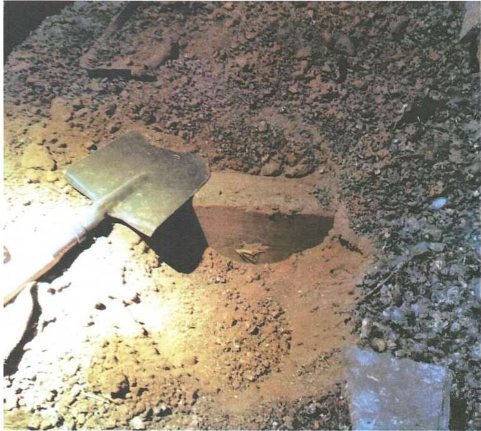
Фото 31. Вскрытие №5 перекрытия 2-го этажа.
