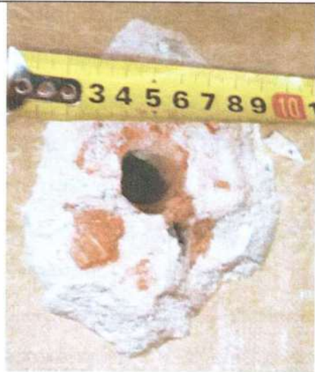
Фото 11. Зондаж №2. Стена 1-го этажа по оси 1 в осях А-Б
