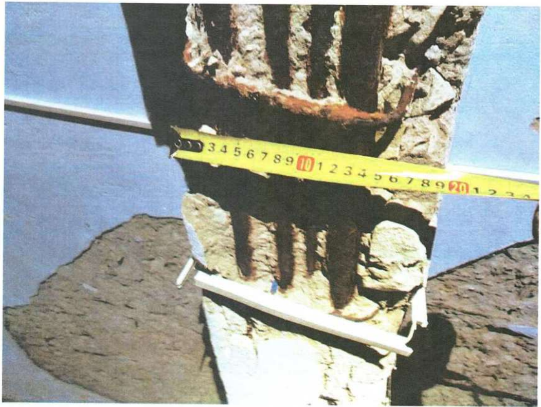
Фото 17. Вскрытие №1 железобетонной балки перекрытия подвала
