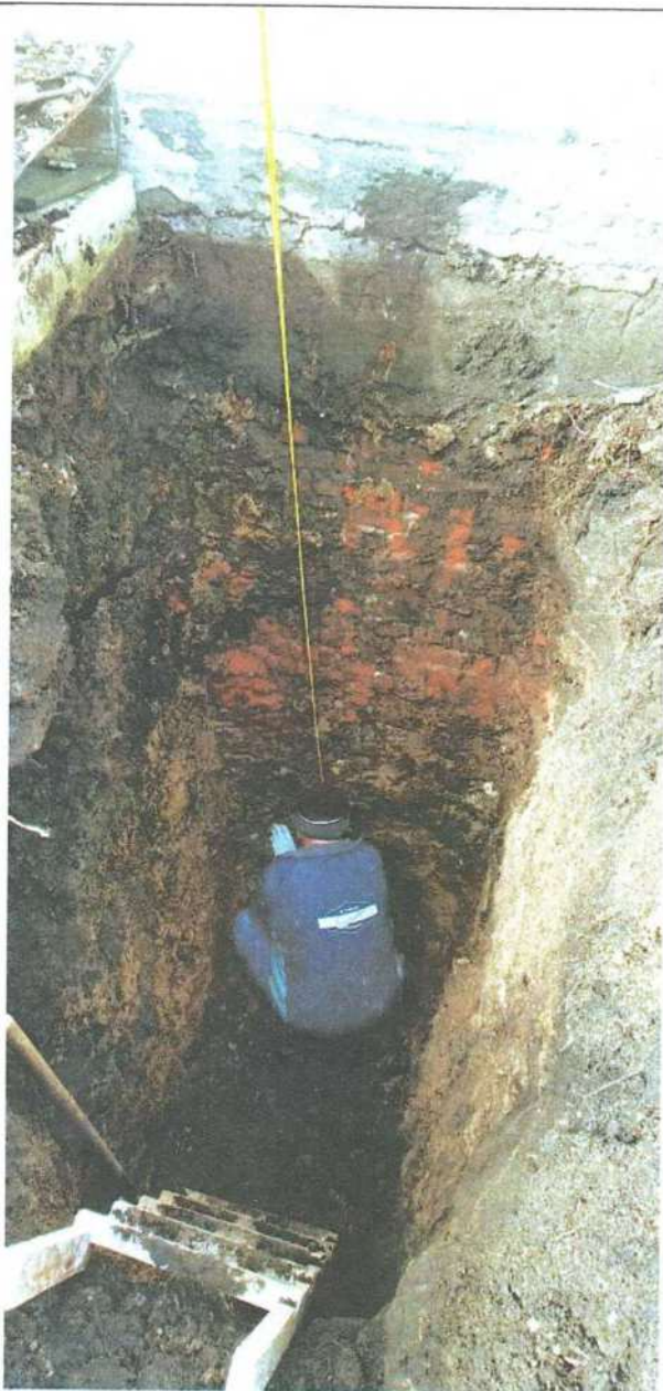
Фото 8. Общий вид шурфа №3
