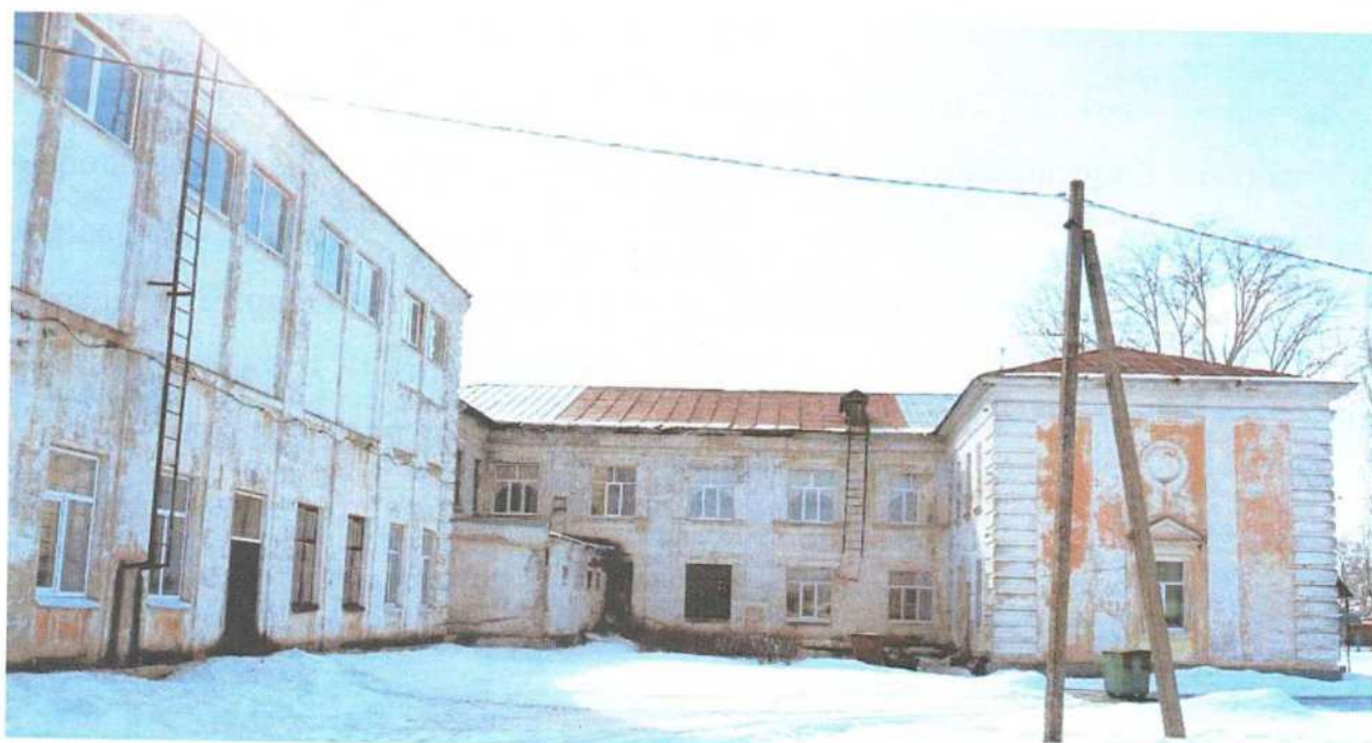
Фото 5. Общий вид здания со стороны дворовых фасадов (дата 27.02.2023 г.)
