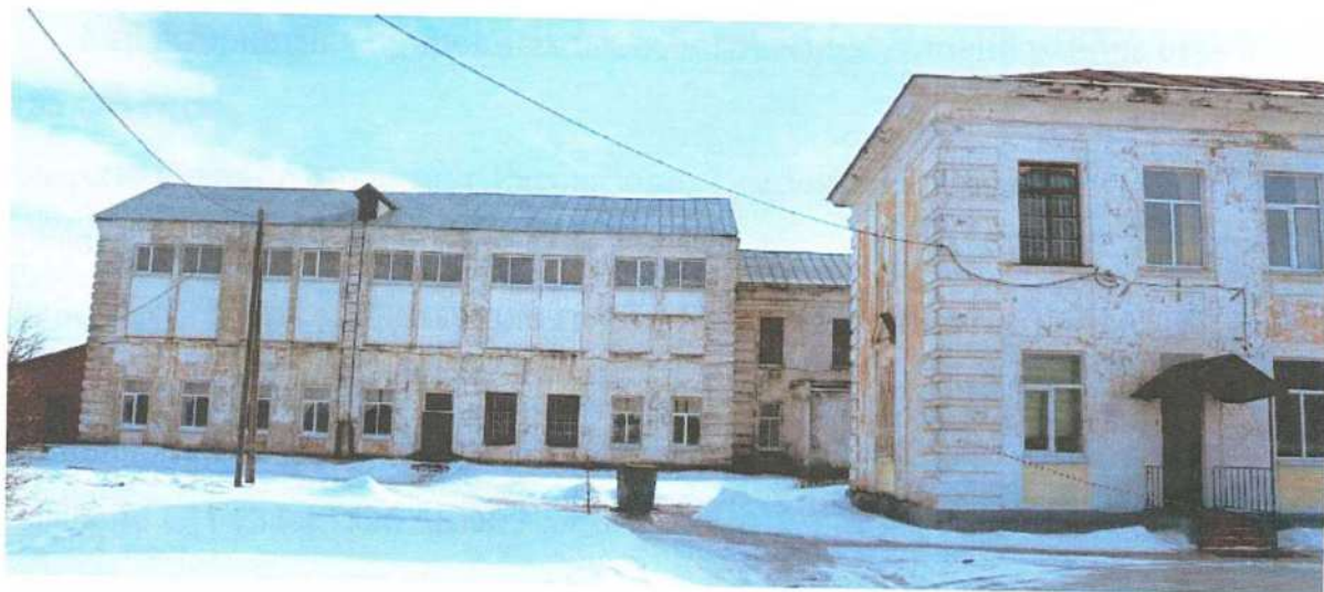
Фото 4. Общий вид здания со стороны бокового фасада (дата 27.02.2023 г.)
