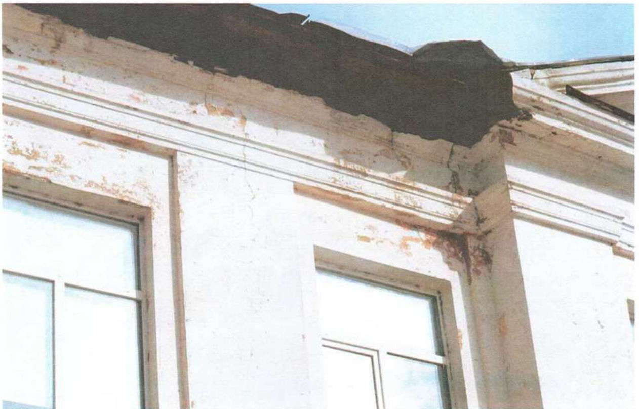
Фото 3. Главный фасад – стена по оси А.
