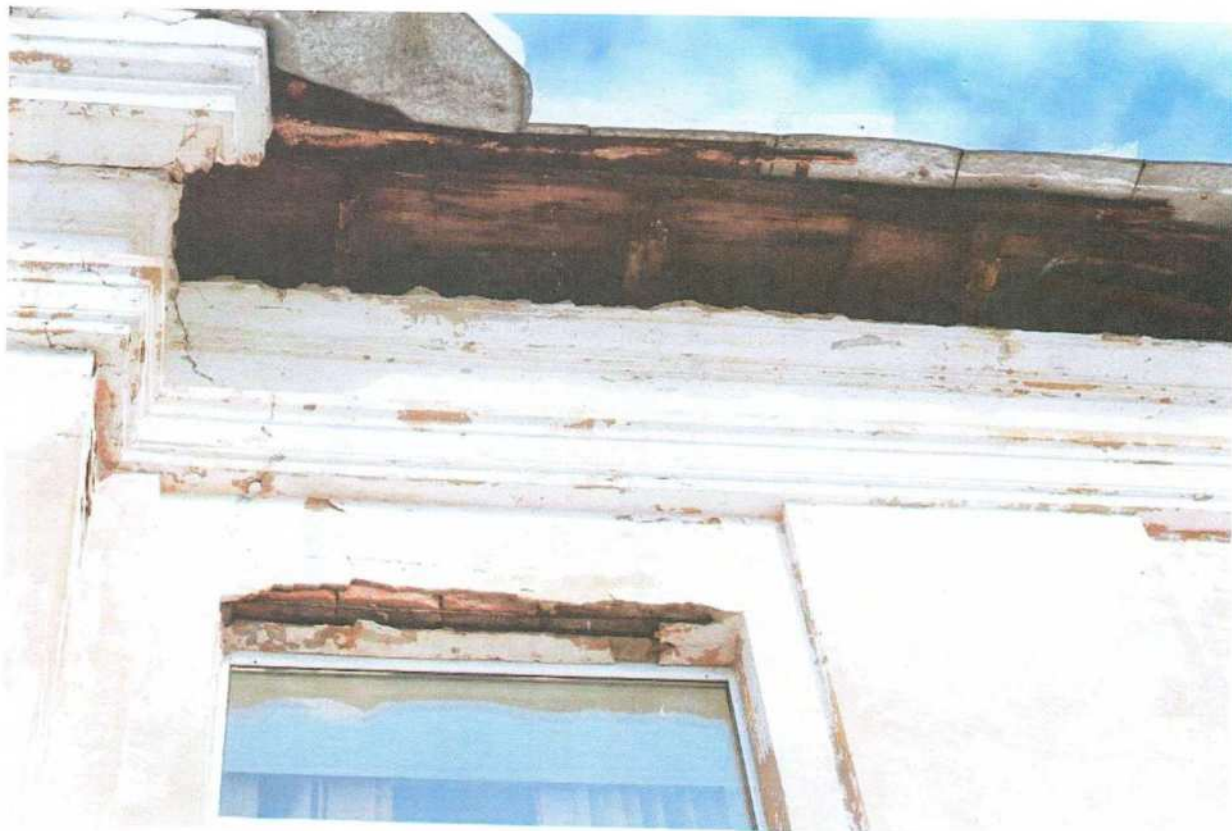
Фото 4. Главный фасад – стена по оси А.
