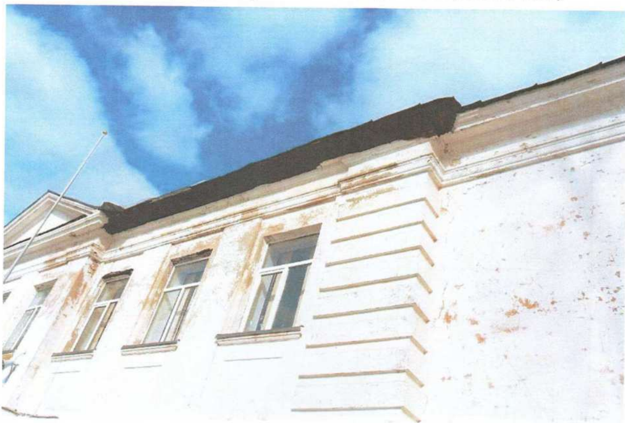
Фото 5. Главный фасад – стена по оси А.
