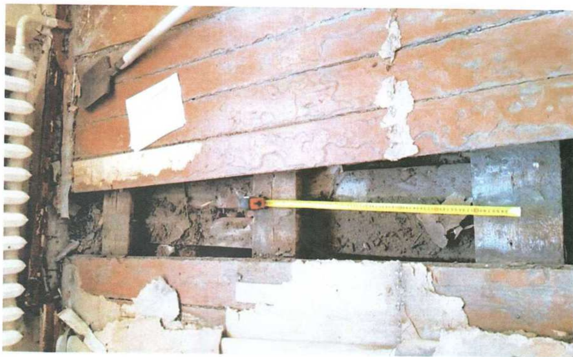
Фото 22. Общий вид вскрытия №2 перекрытия 1-го этажа
