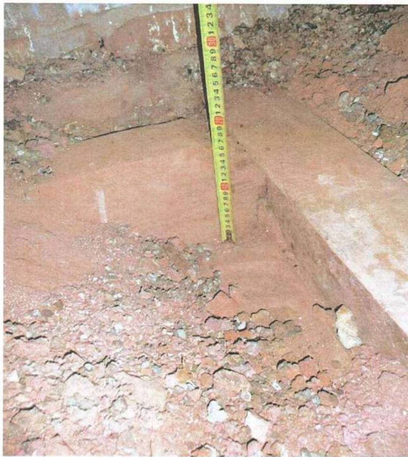
Фото 28. Вскрытие №3 перекрытия 2-го этажа.
