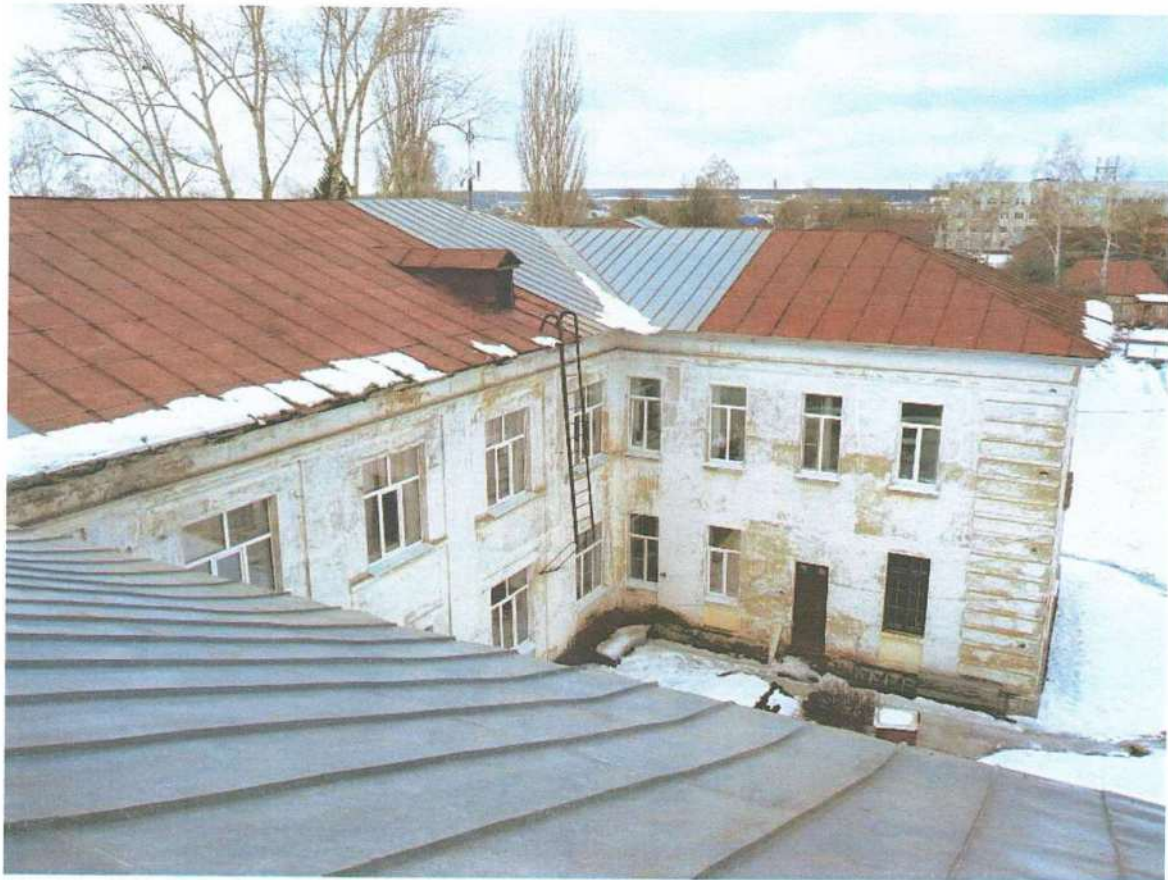
Фото 41. Общий вид кровли здания
