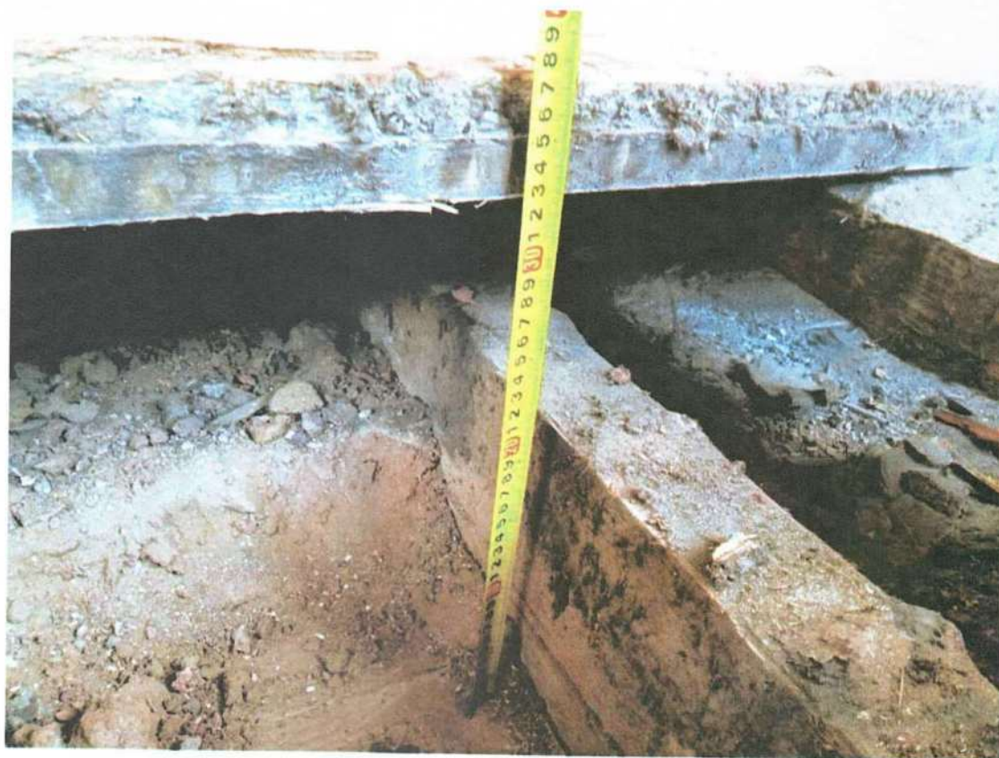
Фото 21. Вскрытие №1 перекрытия 1-го этажа
