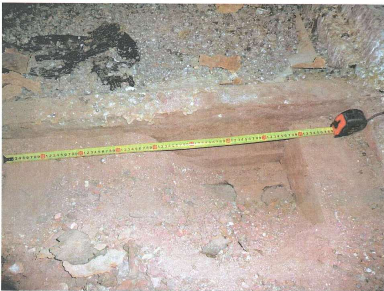
Фото 29. Вскрытие №4 перекрытия 2-го этажа.
