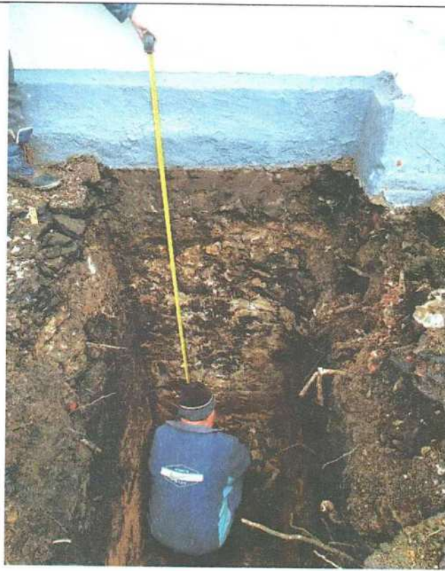
Фото 6. Общий вид шурфа №1
