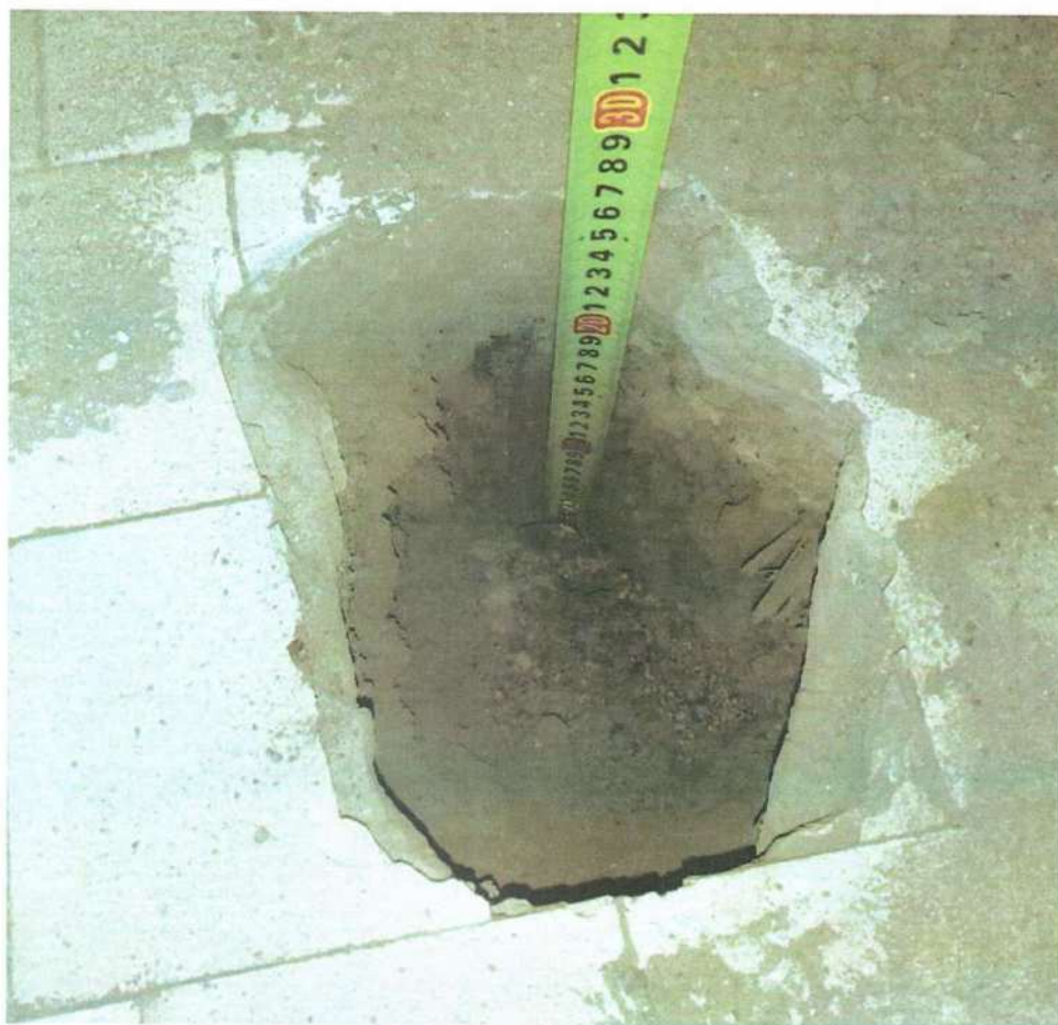
Фото 16. Общий вид зондажа перекрытия подвала
