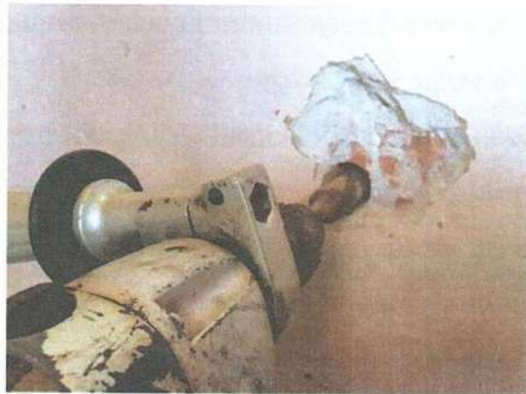
Фото 10. Зондаж №1. Стена 1-го этажа по оси 1 в осях Ж-З
