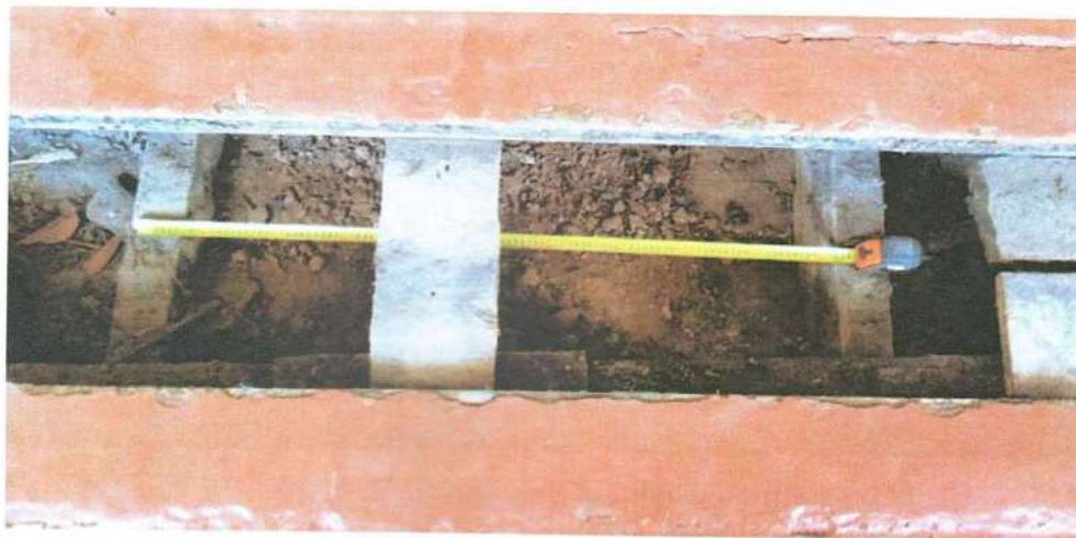
Фото 19. Вскрытие №1 перекрытия 1-го этажа
