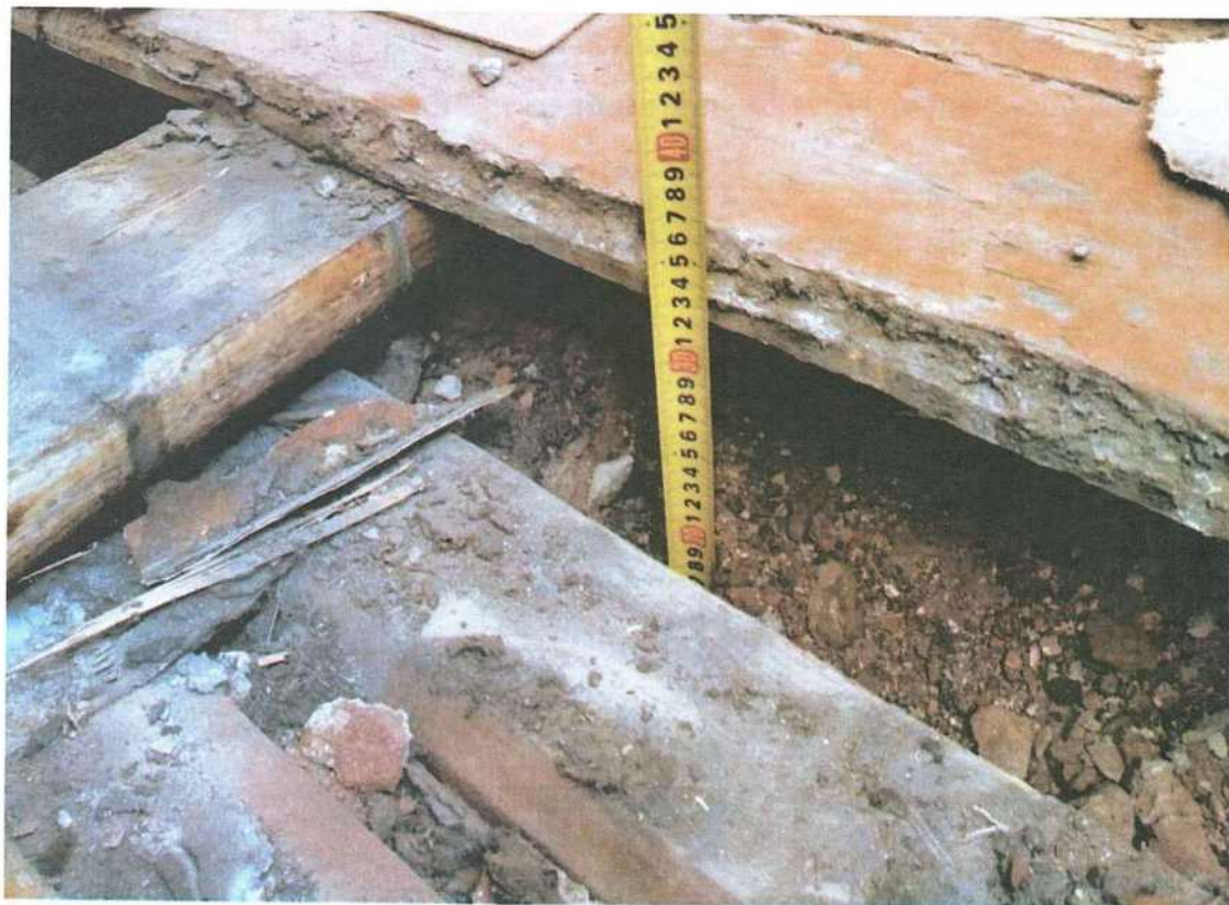
Фото 23. Вскрытие №2 перекрытия 1-го этажа.
