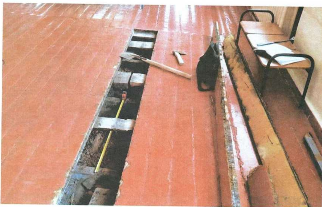
Фото 20. Общий вид вскрытия №1 перекрытия 1-го этажа
