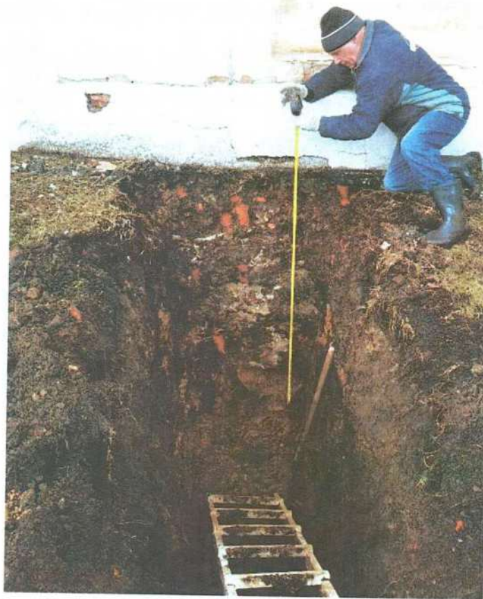
Фото 9. Общий вид шурфа №4
